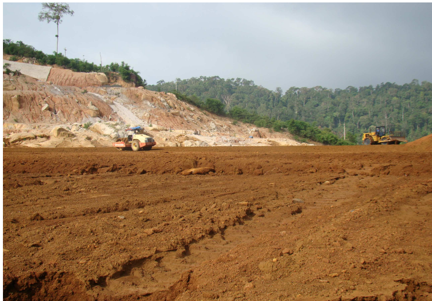
(Ảnh: Thi công đập vù - Thủy điện Đam'bri)
